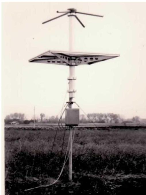
Abb. 6. Antenne der Mobilen Wetterbildempfangsanlage mit Kreuz-Dipol, Reflektorgitter und Antennenvorverstärkern (für jeden Dipol ein Vorverstärker). (Quelle: Private Fotosammlung von D. Oertel)
