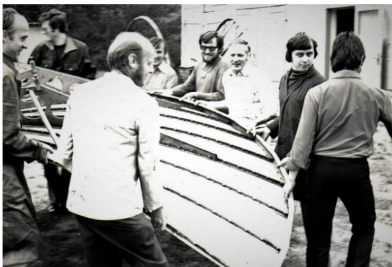
Abb. 2. Dr. Robert Knuth, halb links vorn im weißen Hemd, beim Transport des Parabolspiegels der ersten S-Band-Antenne der Satellitenbodenstation. (Quelle: Private Fotosammlung von N. Jakowski)
